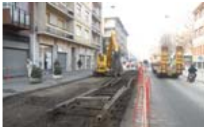
Le vecchie rotaie nascoste dall'asfalto
